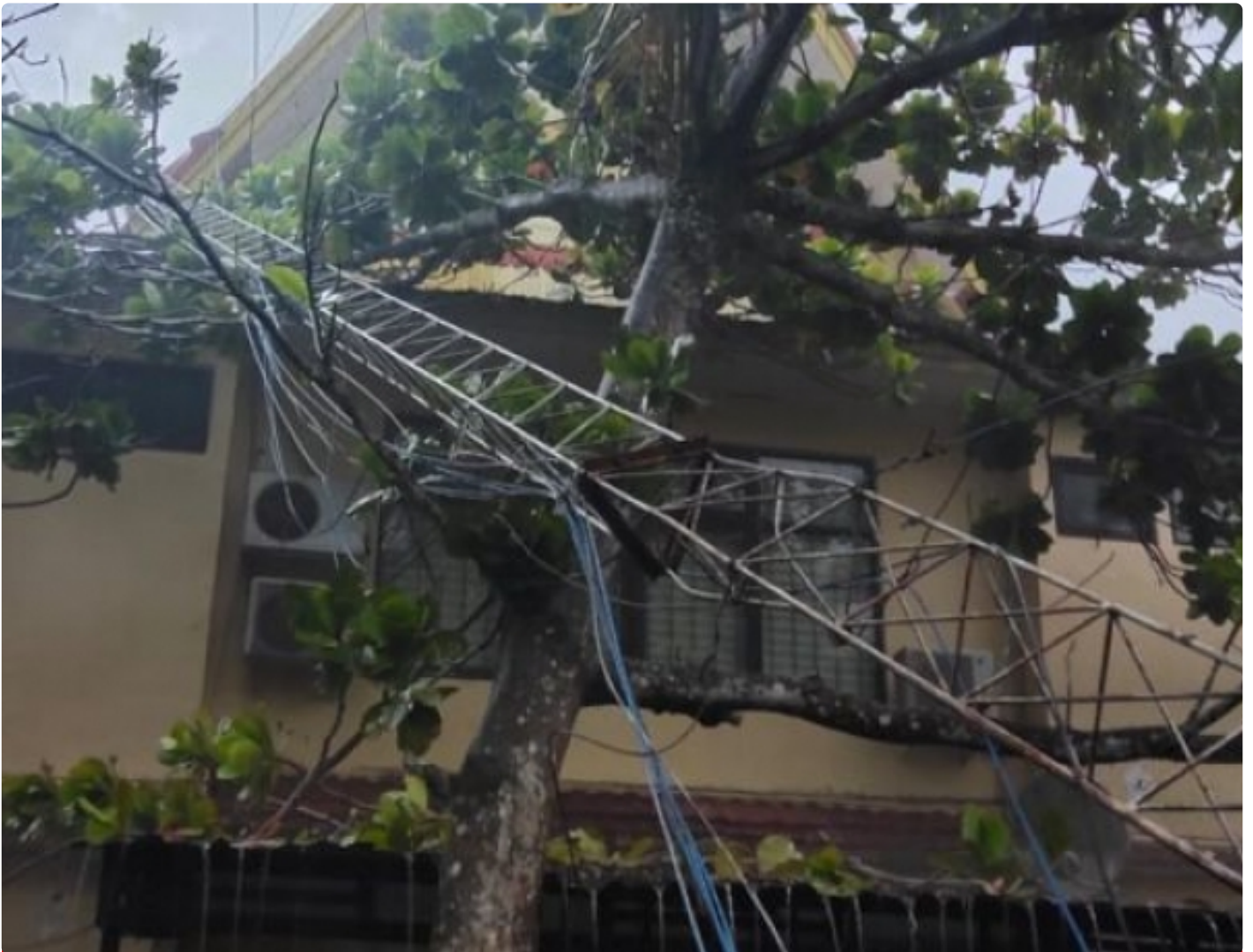
Akibat angin kencang, tower Adminduk Disdukcapil Kuansing roboh
