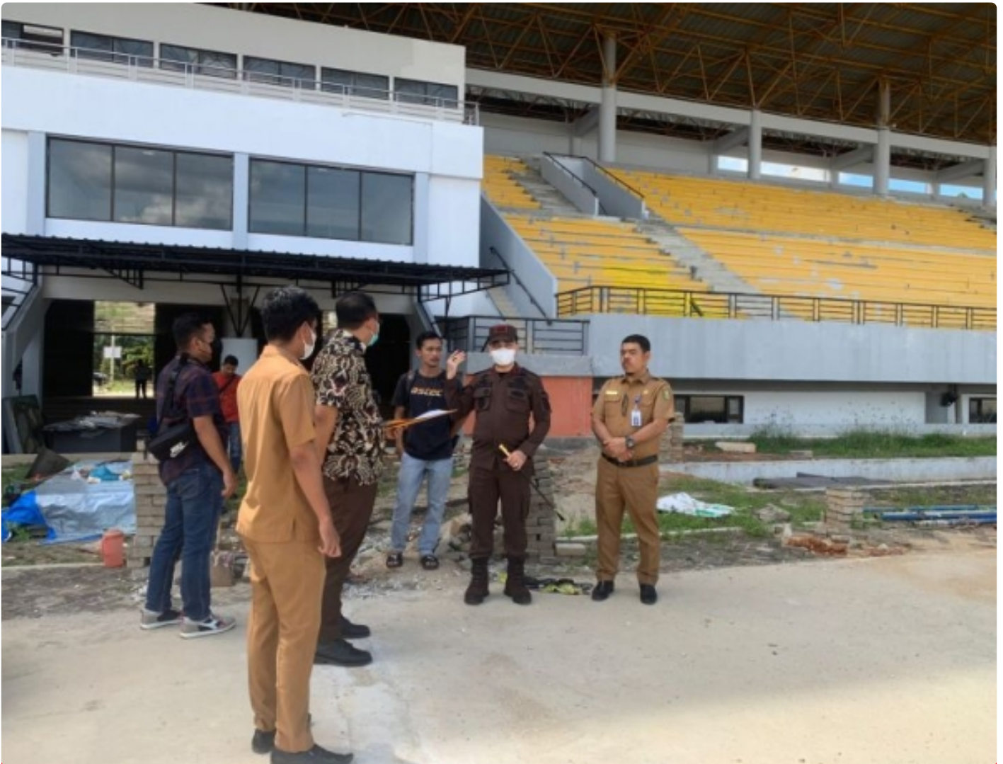
Kejari Kuansing bersama Dikpora Kuansing meninjau proyek Venue Porprov Riau
